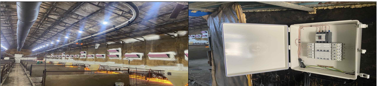
축산농가 화재예방 노후전선 교체 사업사진
