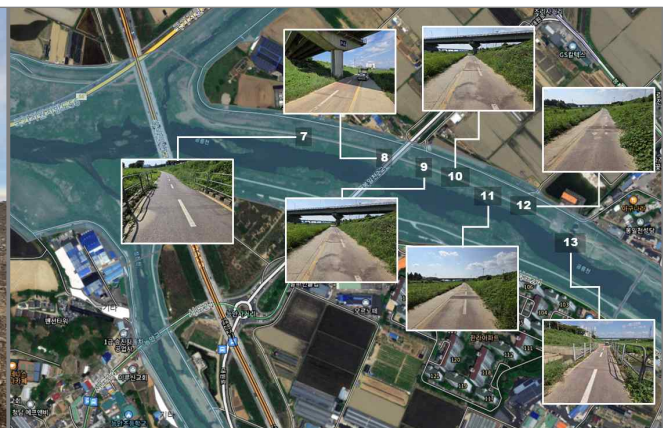
공릉천 자전거도로 보수
