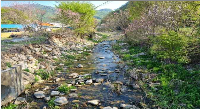
윗배우니천 정비사업(공사 중)
